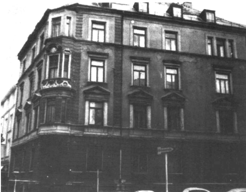
Abrißgebäude in der Maxvorstadt
